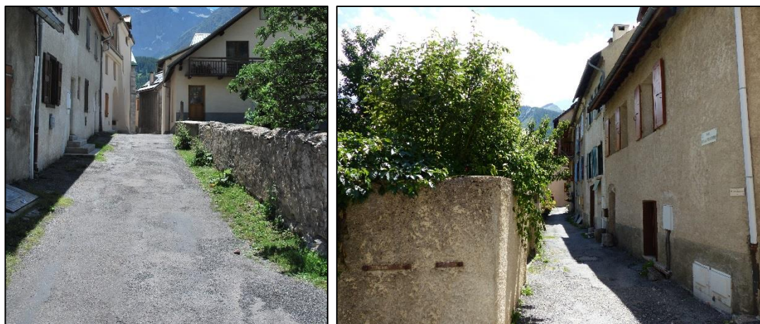
Photographies 49 et 50 : Voirie de qualité médiocre sur la rue de la Fontaine et sur la rue de la Fruitière
