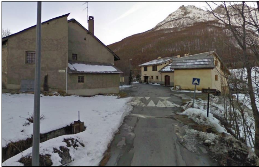
Photographie 14 : Entrée Nord du hameau du Casset Source : www.google.com/maps
