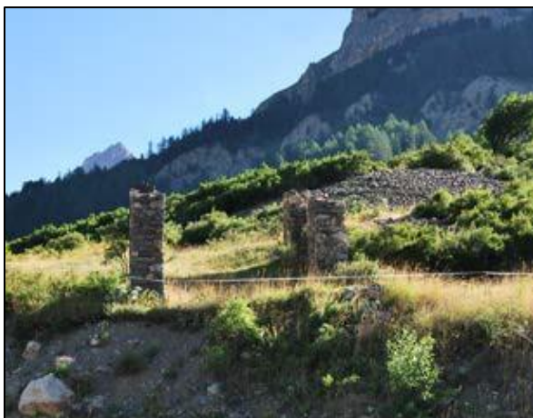
Vestiges du système de câbles de la mine de la Benoite au niveau de la route nationale
