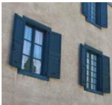
Initialement de petite dimension, les baies ont été progressivement agrandies à partir du XVIII e siècle (menuiseries à petits carreaux) puis au XIX e siècle (grands carreaux).
