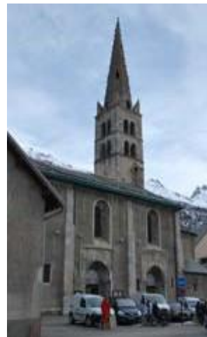
Notre-Dame de L'Assomption, église du Monétier Construite au XVe siècle, clocher reconstruit en 1617 Clocher lombard à quatre pyramidions, typique du Briançonnais, voisine avec un clocheton ancien. Les frises lombardes décorent tout le pourtour des toitures et surmontent ses deux portails de la façade sud.
