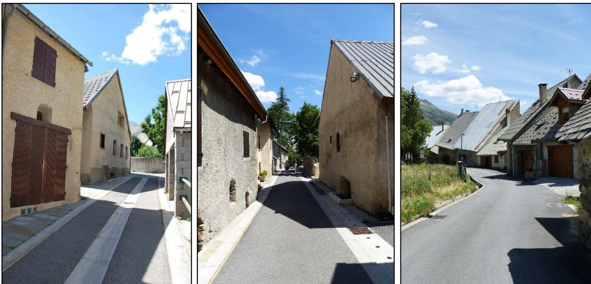
Photographies 46, 47 et 48 : Voirie de bonne qualité sur la rue de Bretagne et la rue des mineurs
