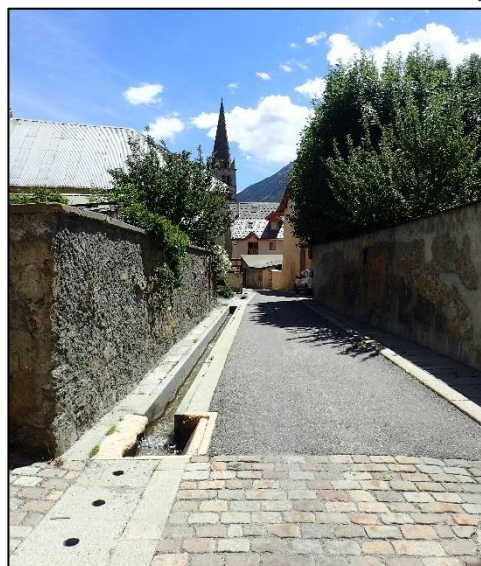
Photographie 33 : Canal le long d'une rue adjacente à la place de l'Eglise
