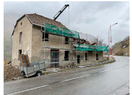
➤ Déconstruction maison Pont de l'Alp
