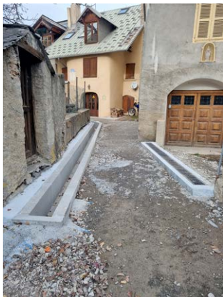
➤ Rue de la Rotonde (fin des travaux en 2023)
