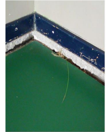
mouvement de sol, détérioration de la dalle
